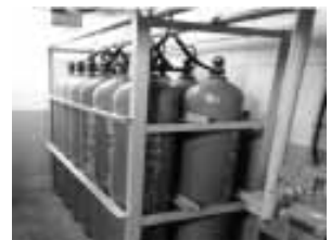
*消火設備の例(写真と本文は関係ありません。)
