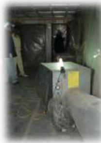
隔離養生区画内（除去作業前）
