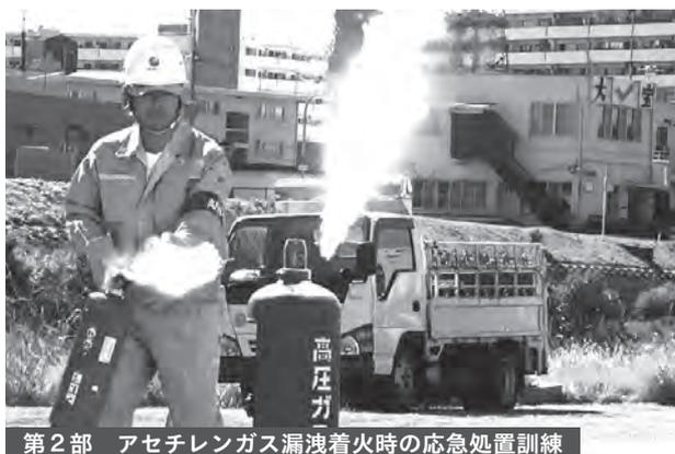
第 2 部 アセチレンガス漏洩着火時の応急処置訓練
